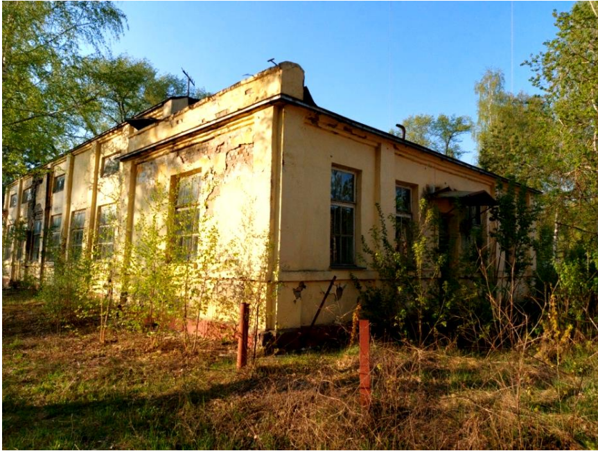
Центральная компрессорная (современное строение).
