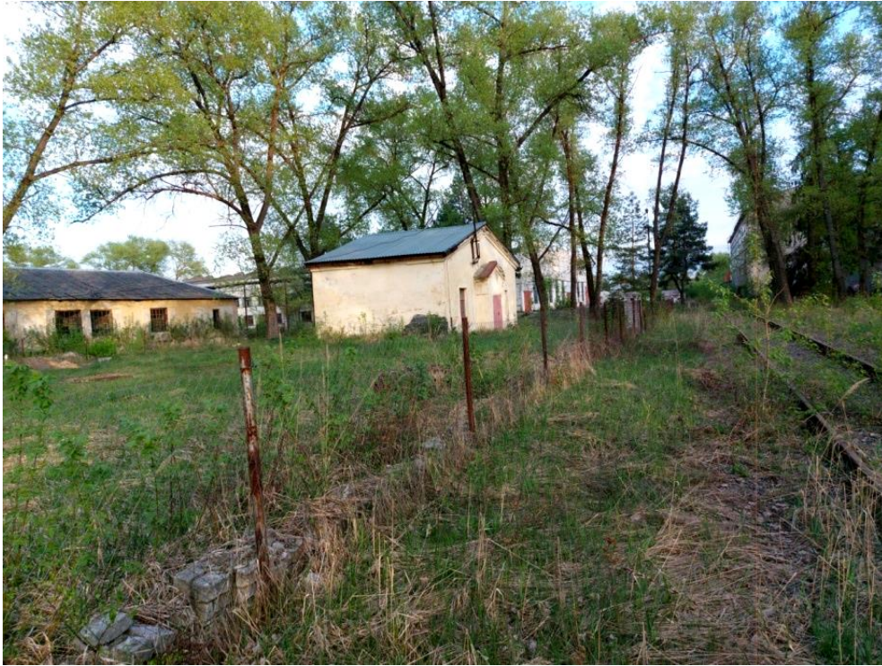
Сантехнический участок (современное сооружение).
