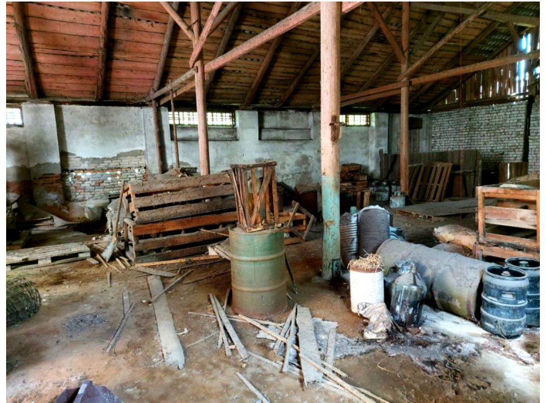
Обстановка внутри помещения кузницы (мемориальное строение).
