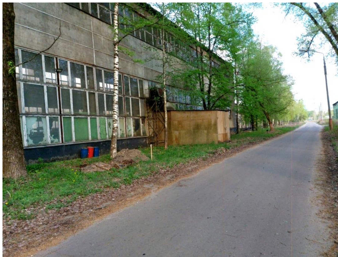
Здание ремонта деталей (современное строение в виде пристройки к мемориальному строению мебельных мастерских).
